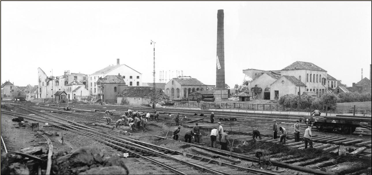
Vrij snel na de bevrijding op 30 oktober 1944 begon het herstel aan en het opnieuw leggen van sporen en wissels aan de zuidzijde van het emplacement. Een passerende machinist fotografeerde vanaf zijn locomotief de diverse spoorwegwerkers. Op de achtergrond staan de zwaar beschadigde kandijfabriek van Van Gilse en de zuivelfabriek 'Het Anker', waarvan de schoorsteen nog tientallen jaren lang het beeld aan de Oostelijke Havendijk zou bepalen. Foto J. Cremers, Roosendaal.
